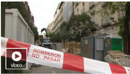
Derrumbe en Salamanca
