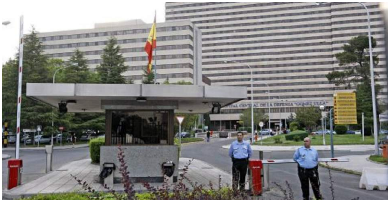
Entrada del Hospital Central de la Defensa Gómez Ulla, en Madrid. BERNARDO PÉREZ
